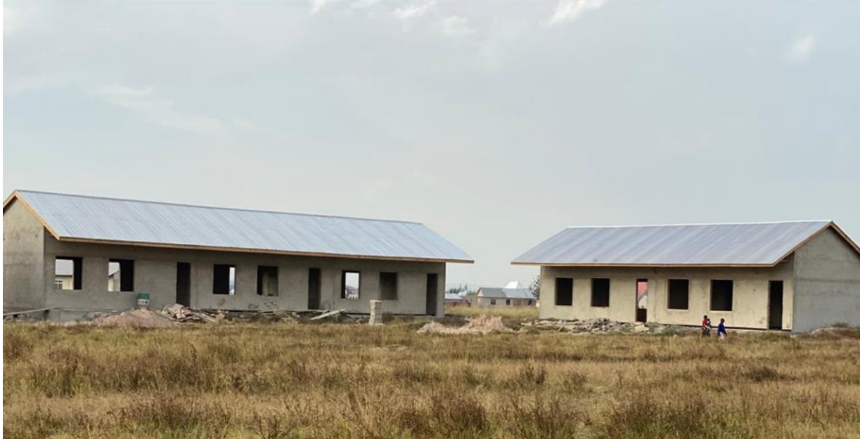
Ujenzi wa Shule mpya ya msingi Muungano ambayo inajengwa kupitia fedha za CSR kutoka Mgodini wa GGM. Shule hii inajengwa kwenye eneo la ekari 8 lililotolewa bure na Diwani wa Kata ya Buhalahala Mhe. Dotto Zanzui Ludeha
