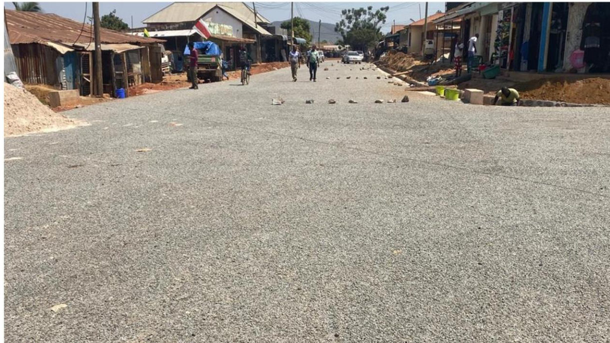
Ujenzi wa Barabara ya Upendo Dispensary- American Chips kwa kiwango cha lami ambao unatekelezwa kwa gharama ya Shilingi Milioni 292 za kitanzania kutoka kwenye chanzo cha mfuko wa barabara (Road fund)
