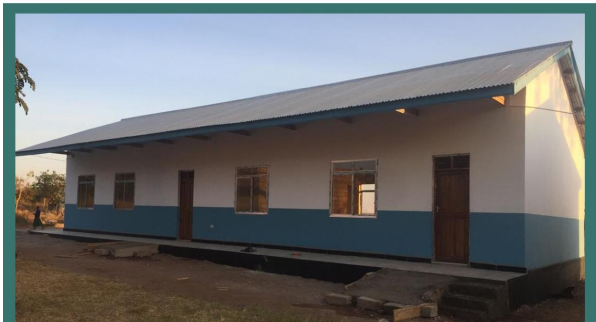
Ujenzi wa madarasa ya kisasa Shule ya Msingi Nyampa Kata ya Kasamwa ambayo yanajengwa kupitia fedha za EP4R.
