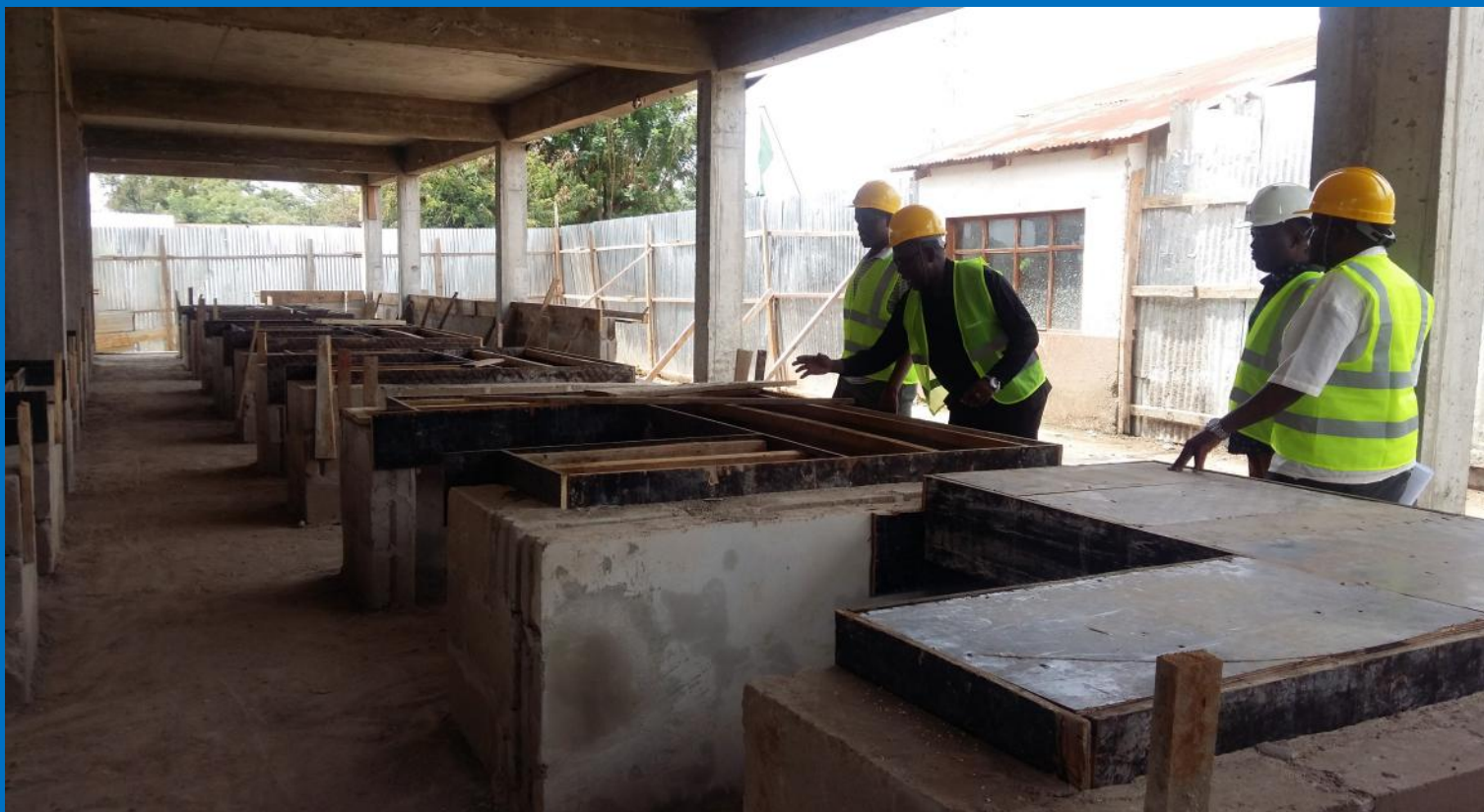
Ujenzi wa vizimba kwenye Soko kuu Geita Mjini.
